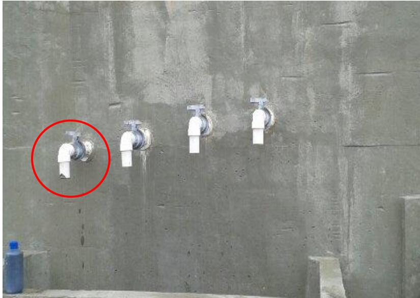
Figura 2. Vista dos registros utilizados para obtenção das amostras no reator.
