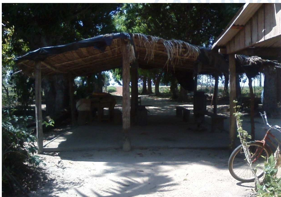
Figura 1: Uma das estruturas antigas da escola indígena Ywará Puruborá
