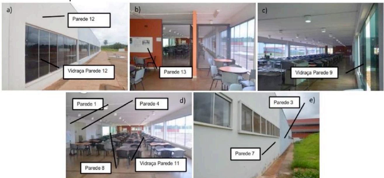
Figura 3. Fotos externas e internas da edificação; a) vista externa do lado leste; b) vista externa do lado sul; c) Vista interna da parede sul; d) Vista interna da parede norte; e) vista externa da parede oeste.
