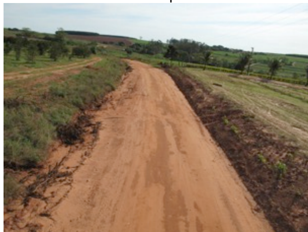
Figura 20: Foto da estrada em Mirassolândia - SP com obra concluída após 2 anos
