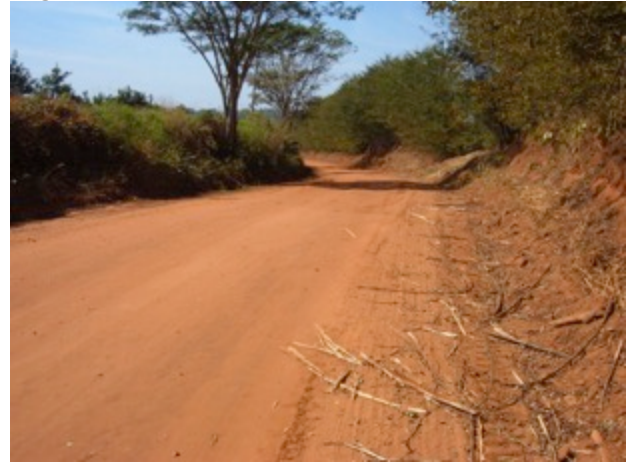
Figura 07: trecho antes da execução da obra
