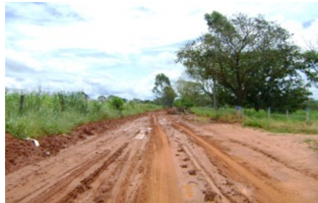
Figura 14: Foto da estrada em Mirassolândia - SP antes do início das obras
