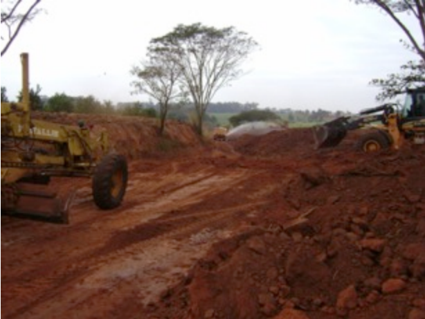
Figura 10: Foto área da estrada em Santa Adélia - SP
