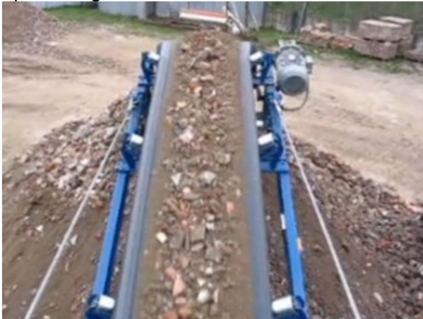
Figura 4: Esteira para destinação do resíduo após britagem
