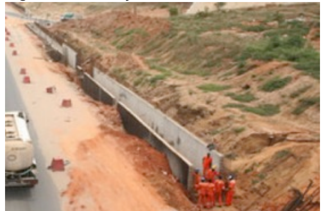
Figura 9: Construção de Valetão Lateral
