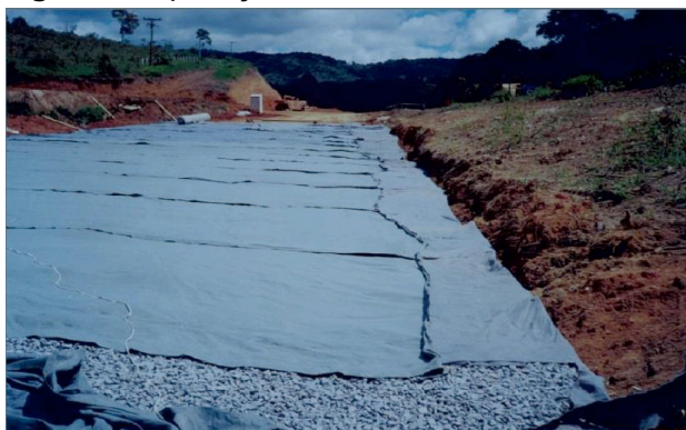
Figura 7: Aplicação do Colchão Drenante
