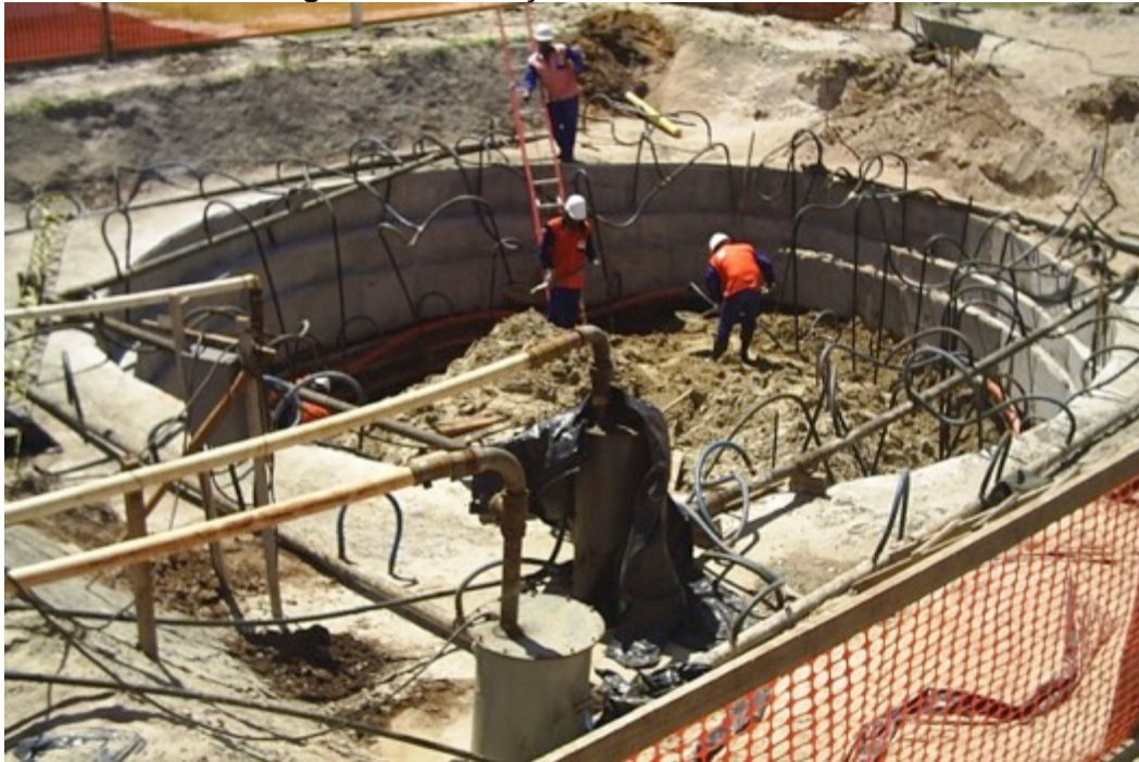
Figura 17: Execução das Ponteiras Filtrantes
