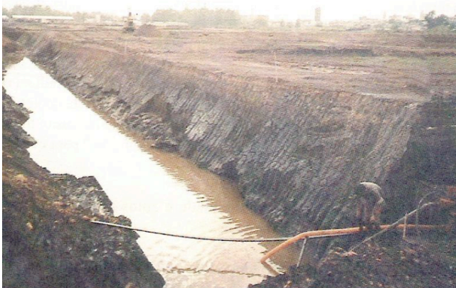
Figura 14: Drenagem por Bombeamento Direto
