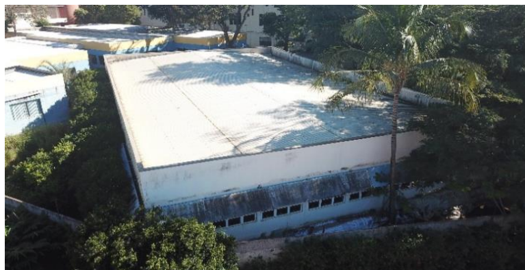
Figura 3. Lateral Direita (SE) da Biblioteca.
