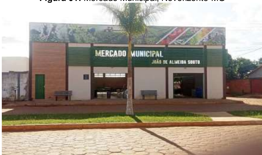
Figura 01: Mercado Municipal, Novorizonte-MG
